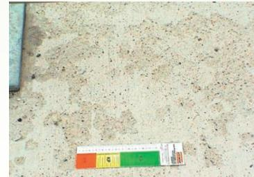
Abwitterung einer dünnen Zementmörtelschicht über der Gesteinskörnung
